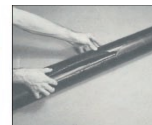
Encapsulez le câble avec le conduit fendu* FRE MD
